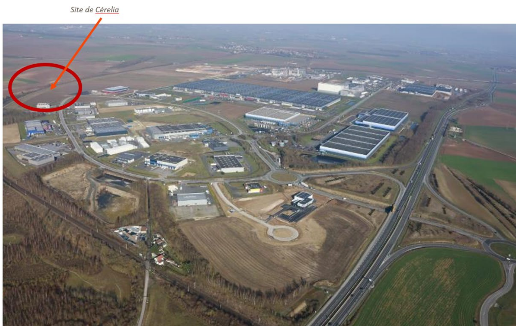
Figure 4 : Localisation approximative du projet CERELIA - Vue aérienne
